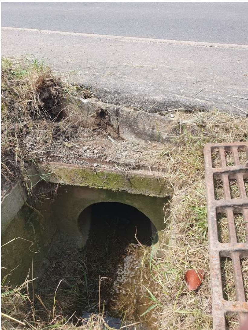
Canalisation qui passe sous la route et sort dans le champ
