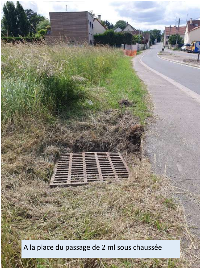
Pluvial qui arrive du collecteur plus haut (diamètre inférieur à la buse sous chaussée)
