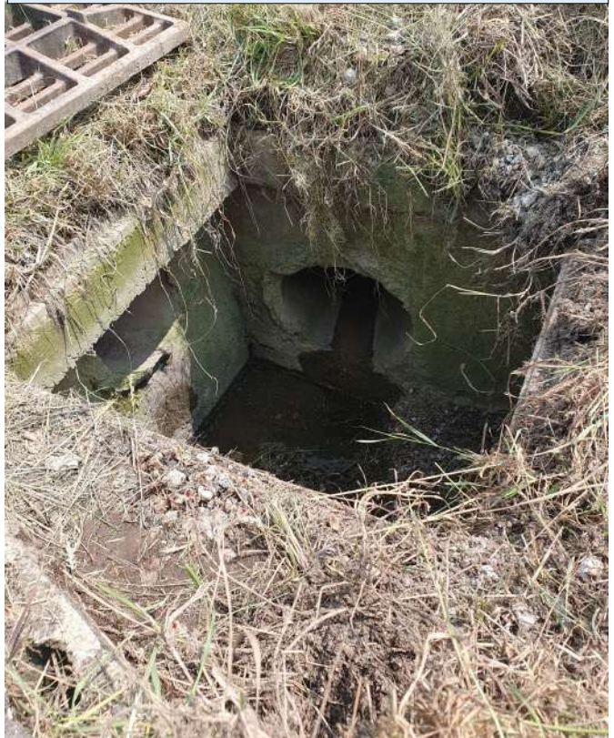
Pluvial qui arrive du collecteur plus haut (diamètre inférieur à la buse sous chaussée)
